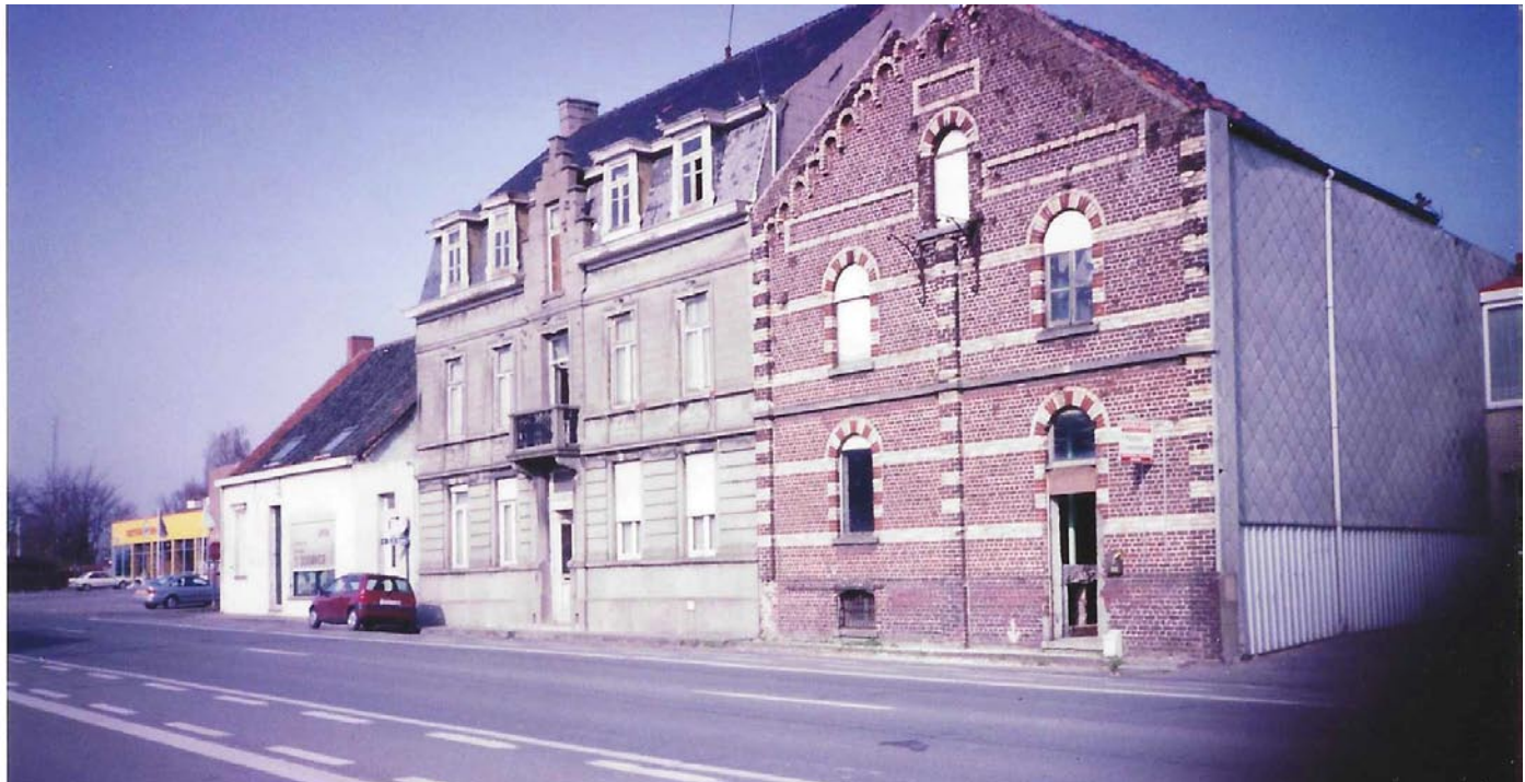
Zicht op de herenwoning en de brouwerij van het echtpaar Vital Masureel en Florence Blanckaert Uit het fotoarchief van Roger Claerhout (*)
